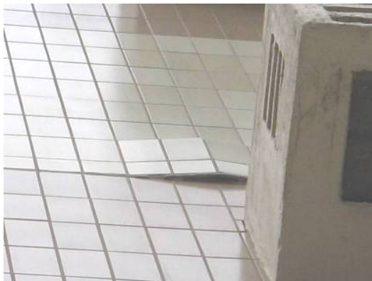
Revestimento de fachada de edifício
